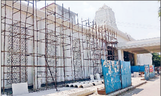
सोनीपत। स्टेशन के मुख्य प्रवेश द्वार पर नए भवन के साथ पुराने भवन में चल रहा रेनोवेशन का कार्य। फोटो : हरिभूमि
